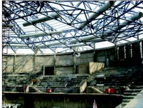
यमुना खेल परिसर में राष्ट्रमंडल खेल-2010 के लिए निर्माणाधीन इन्डोर स्टेडियम
